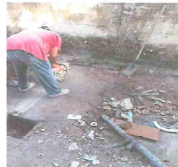
Foto 8: REVISIÓN Y REPARACIÓN DEL SISTEMA DE DRENAJE PLUVIAL.
