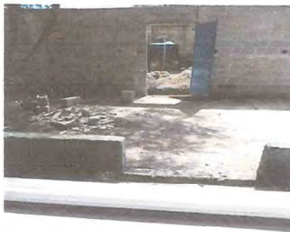
Foto 9: SUSTITUCIÓN DE PUERTA DE ACCESO.
